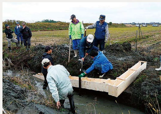
設置作業の様子
