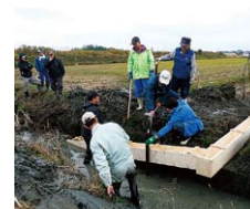
L字式水田魚道の設置の様子
