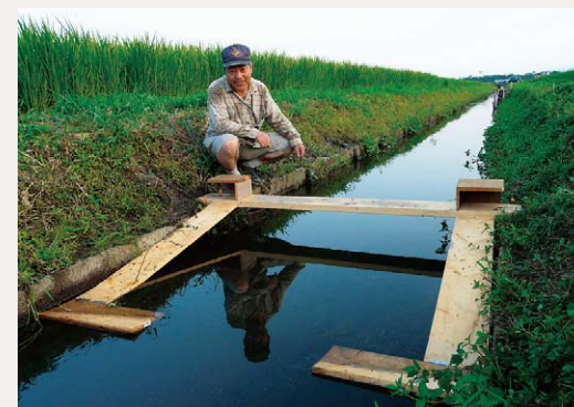
広い水路で用いるダブルタイプの亀かえるスロープ
