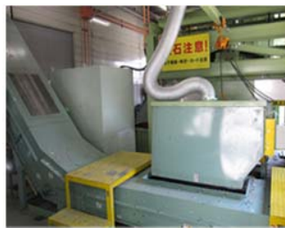
磁選機(写真奥)で金属を除去
