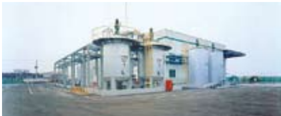
燃料化施設(製造所建設当時)
