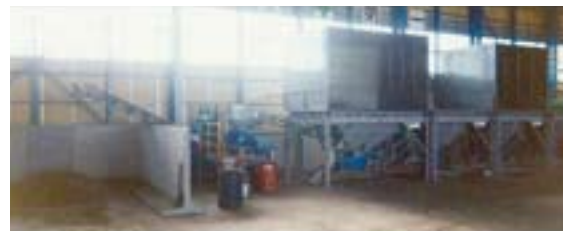
金属原料化施設(製造所建設当時)
